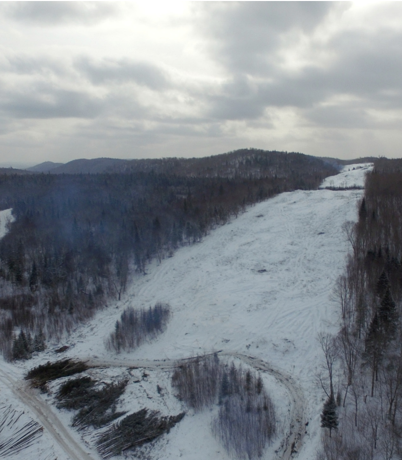
Résultat des travaux effectués
