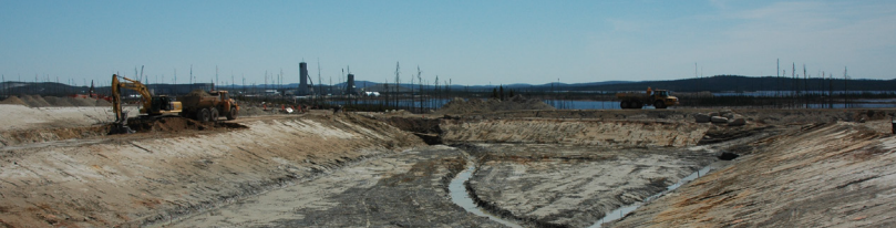
Confection des bassins de traitement des eaux usées
