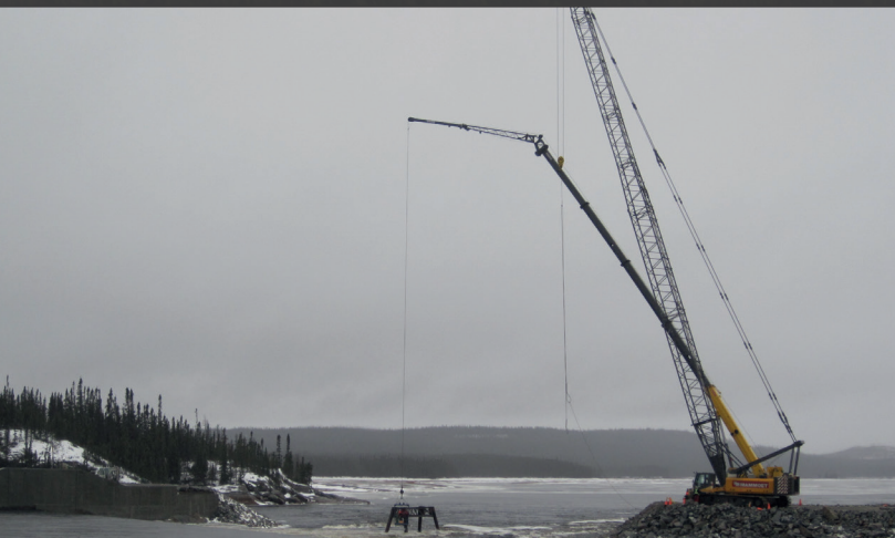
Enlèvement des pieux de ponts Bailey
