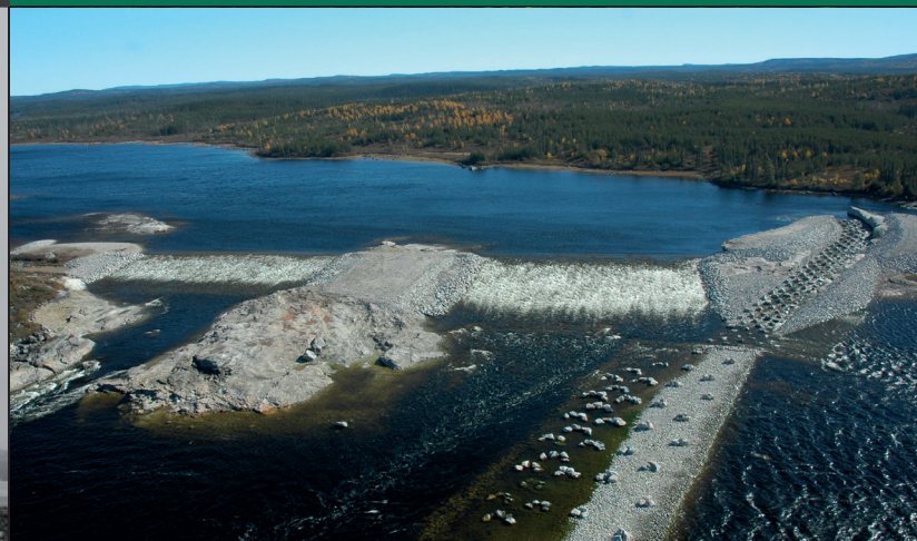
Seuil au point kilométrique 290 avec passe à poissons
