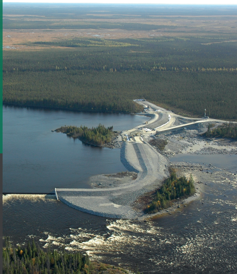
Seuil au point kilométrique 33 (bétonnage sous-marin en partie)
